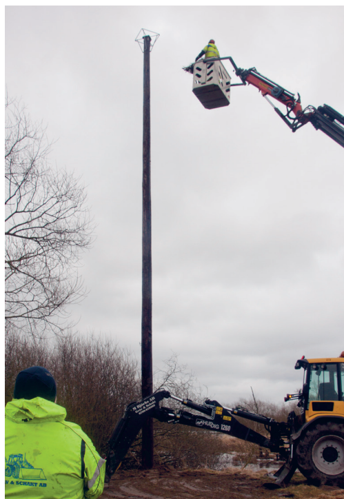
Plattformen måste vara väl förankrad för att klara väder, vind och tidens tand.
